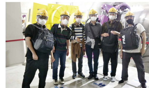
ゼミ合宿（ハッ場ダム発電所タービン見学）
