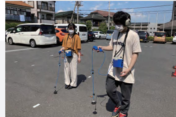
漏水検知機器を使い、地面の下にある漏水箇所を発見する研修
