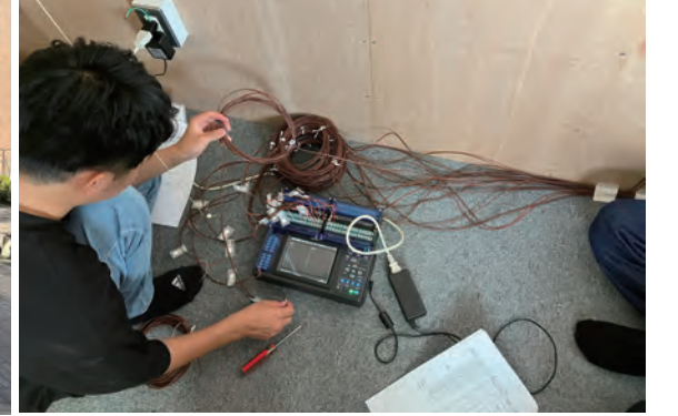
室内温熱環境計測用センサーの設置
