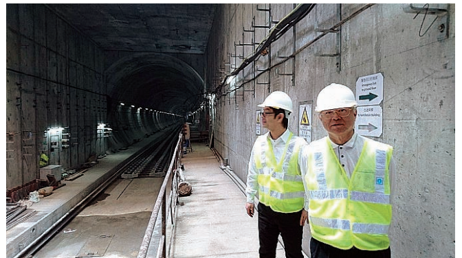
図 5 建設現場の写真
