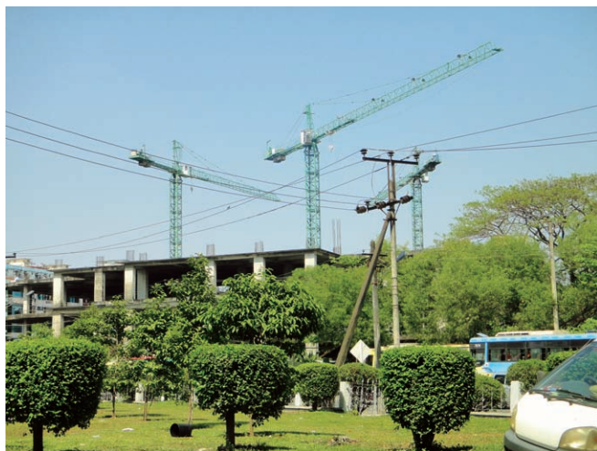
写真-11 街のあちこちに立つクレーン
