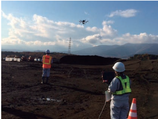
写真2 飛行 (測量) 状況
