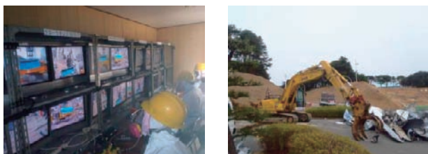
図24 福島原子力発電所への無人化施工技術の導入
