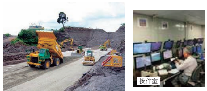
図23 建設機械の遠隔操作による無人化施工技術
