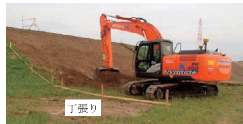
図11 法面造成工事の状況（山岡組提供）
