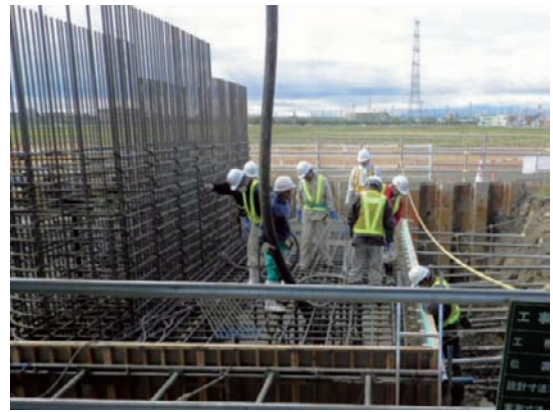
写真－２ 目標スランプ 8cm の打込み状況
