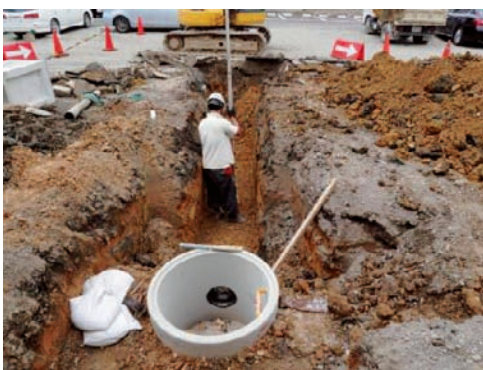
図10 下水管の埋設工事の状況
