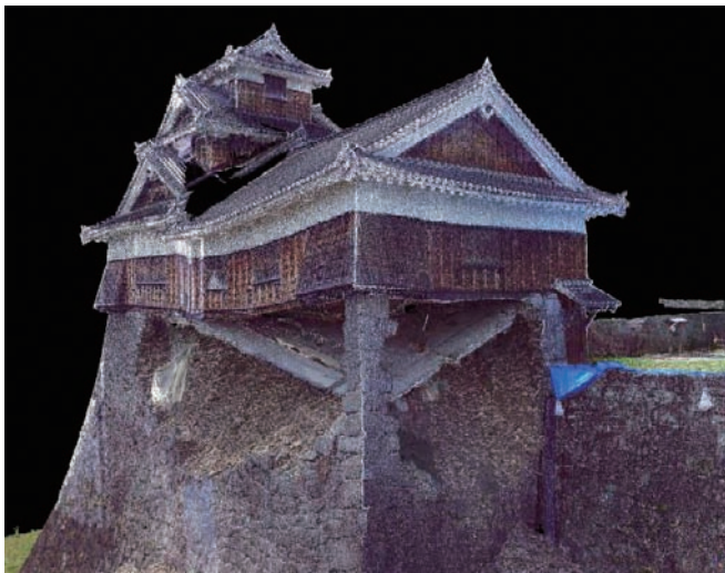
図 24 3D 測量画像（飯田丸五階櫓南東側より）
