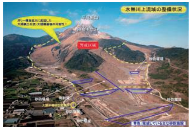
図22 雲仙普賢岳における砂防事業 (国土交通省九州地方整備局雲仙復興事務所)
