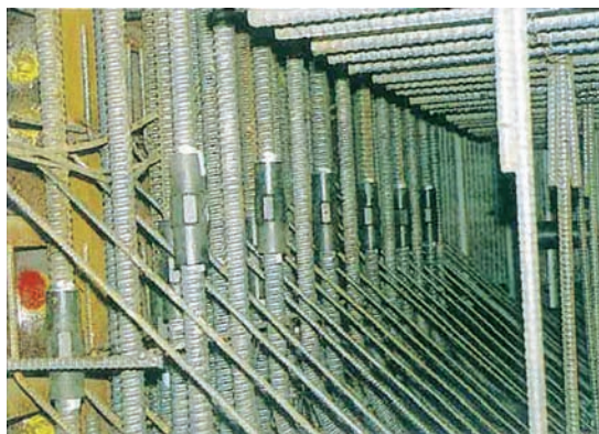
写真-4 機械式鉄筋継手工法の施工事例
