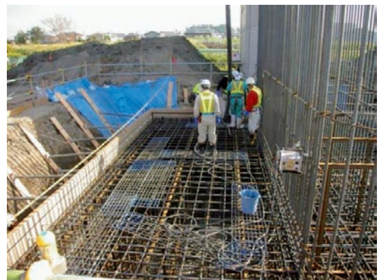
写真－３ 目標スランプ 12cm の打込み状況
