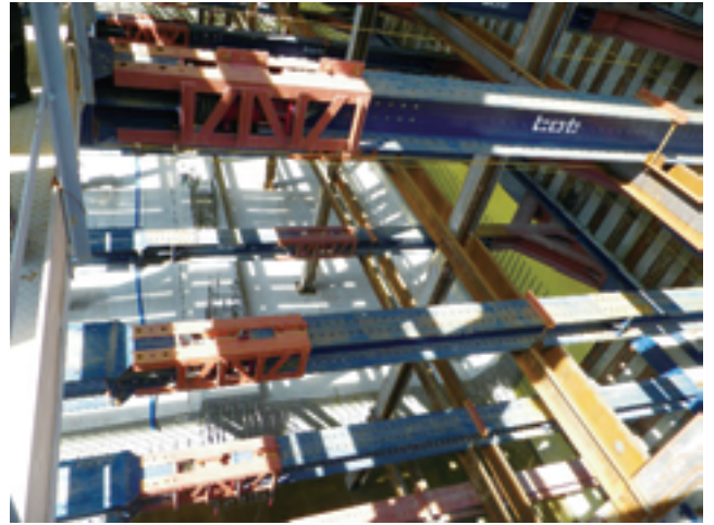
写真-7 函体底盤部
