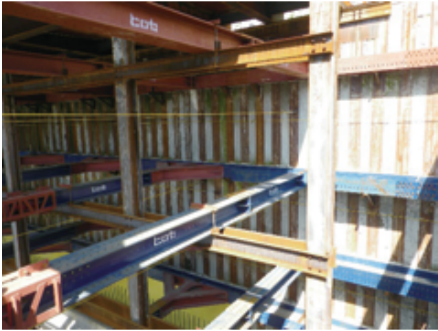
写真-6 土留支保工
