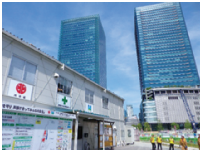
写真-4 現場状況 1
