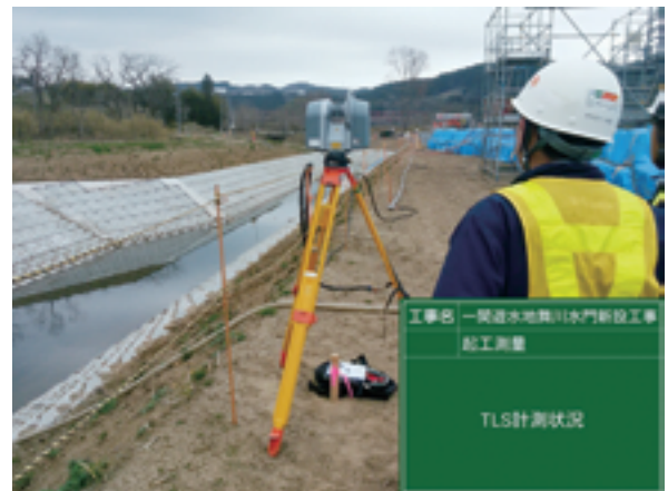
写真 1 TLS 測量状況
