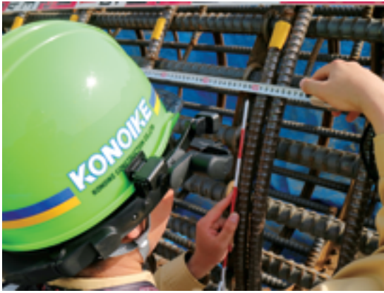
写真7 現場での検査状況
