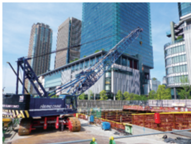
写真-5 現場状況 2
