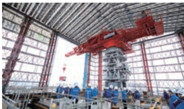
図8-2 水平スライドクレーン EXTER
