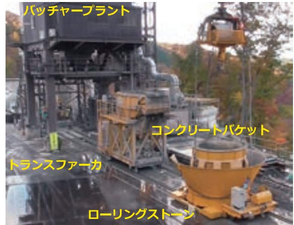
図 4-3 バッチャープラントからコンクリートバケットへの運搬積み込み
