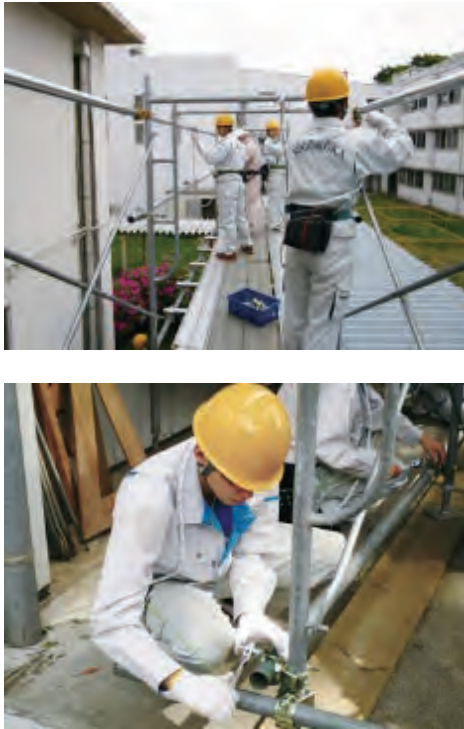
図 3 作業足場組立実習
