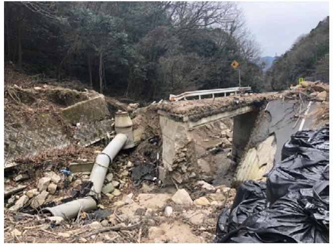
図7 土砂崩れにより道路と下水管が被災。
