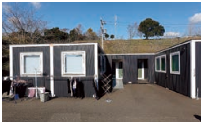
写真9 2020年球磨川水害で利用されたムービングハウスの応急仮設住宅
