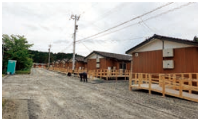
写真7 2024年能登半島地震で建設された木造応急仮設住宅
