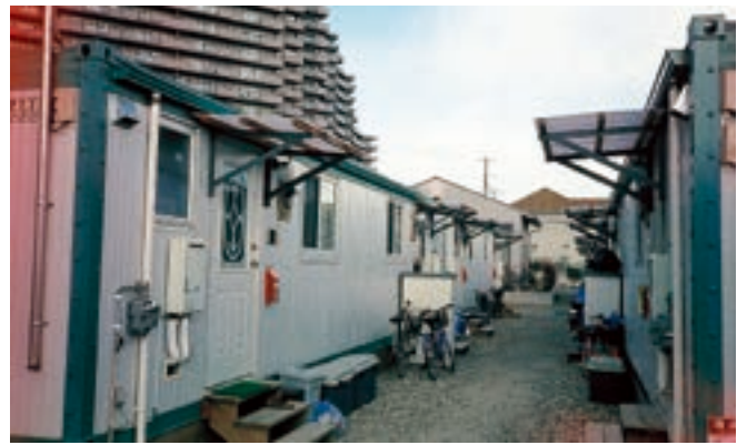
写真4 イギリスから輸入された応急仮設住宅（鉄骨ユニット）
