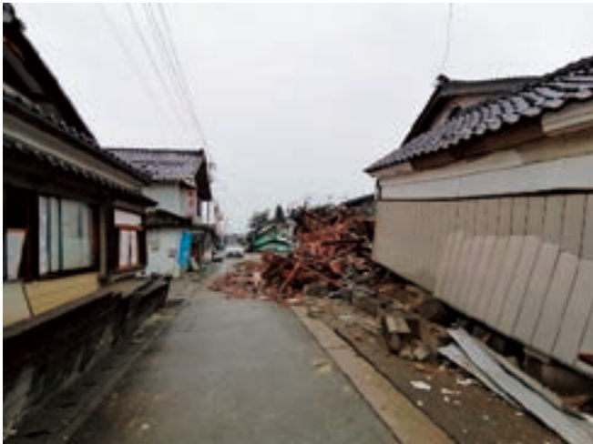
写真5 珠洲市正院地区
