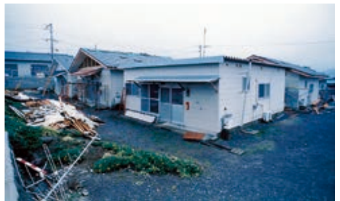
写真2 木造応急仮設住宅を改造して公営住宅として利用（雲仙普賢岳噴火災害）
