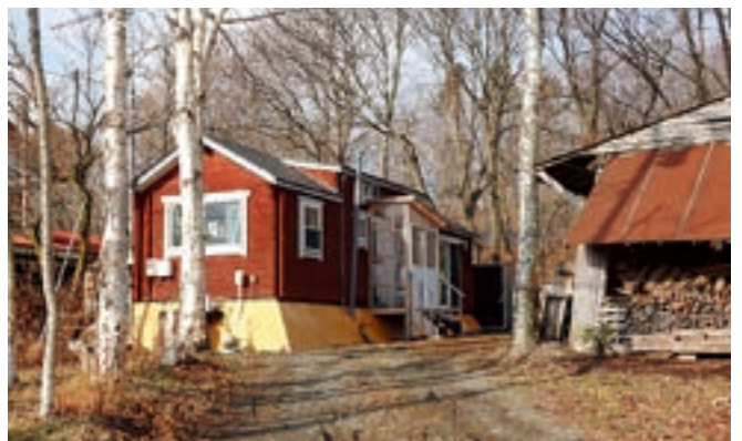
写真8 2018年北海道胆振東部地震で利用されたトレーラーハウスの応急仮設住宅
