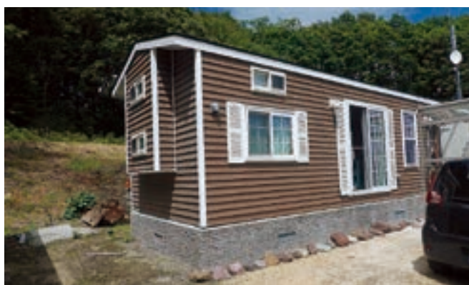
写真10 北海道胆振東部地震で恒久住宅化されたトレーラーハウスの応急仮設住宅
