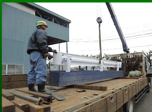
仮設ガードレール設置工
