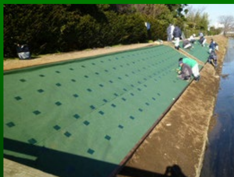
防草シート設置工
