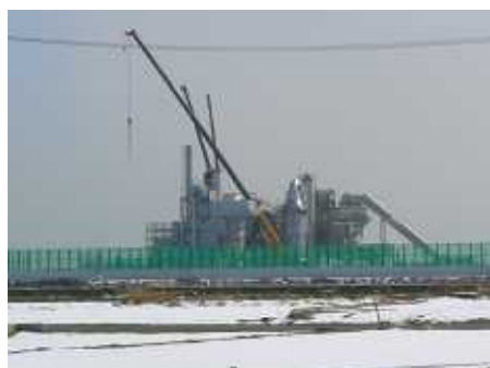
（建設中のガレキ処理プラント：宮城県名取市）
