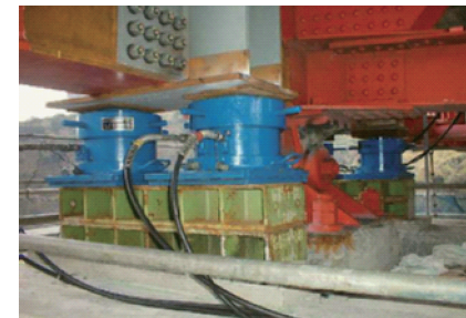
②ジャッキアップ
