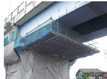
①橋脚周り足場（一部桁下吊足場兼用）(1)
