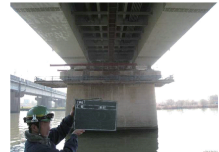
②橋脚周り足場（一部桁下吊足場兼用）(2)
