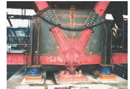
(参考) ジャッキ受け部補強（トラス橋）
