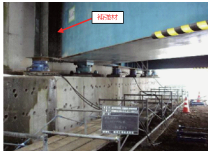
①反力受け台（箱桁橋）
