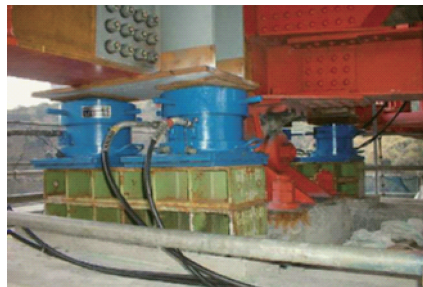
②ジャッキアップ
