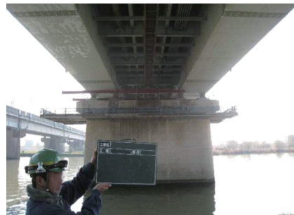
②橋脚周り足場（一部桁下吊足場兼用）(2)
