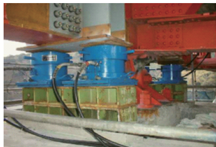
②ジャッキアップ
