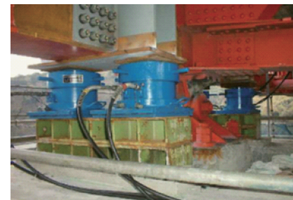
②ジャッキアップ
