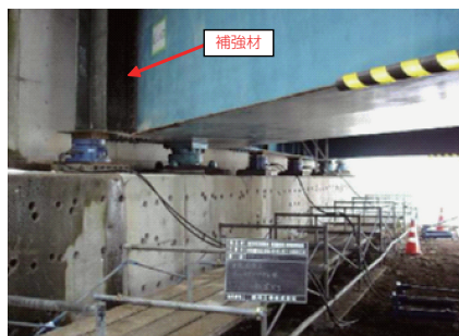
①反力受け台（箱桁橋）
