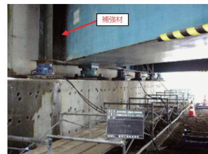
①反力受け台（箱桁橋）
