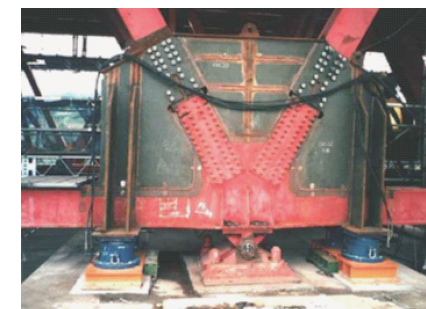
(参考)ジャッキ受け部補強（トラス橋）
