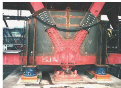
(参考)ジャッキ受け部補強（トラス橋）
